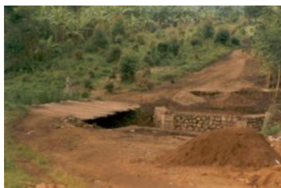
Foto1: de oude brug (links) met ernaast de fundamenten van de nieuwe brug.
