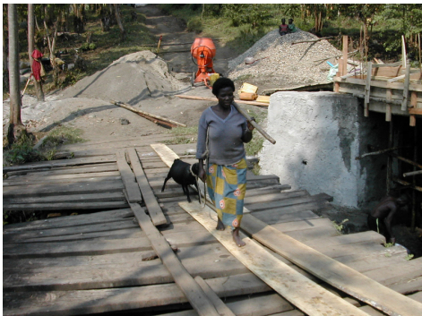
De oude brug nog in gebruik...
